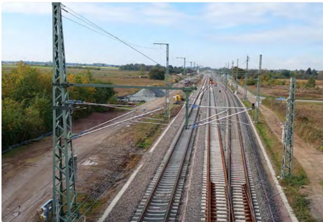
Rheinbahn und Neubaustrecke sind an der Abzweigstelle Bashaide miteinander verbunden.
