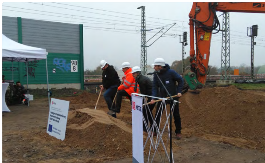
Mit dem „ersten Spatenstich“ läutete die Bahn gemeinsam mit der Stadt Rastatt und der Baufirma Schleith den Baubeginn ein.
